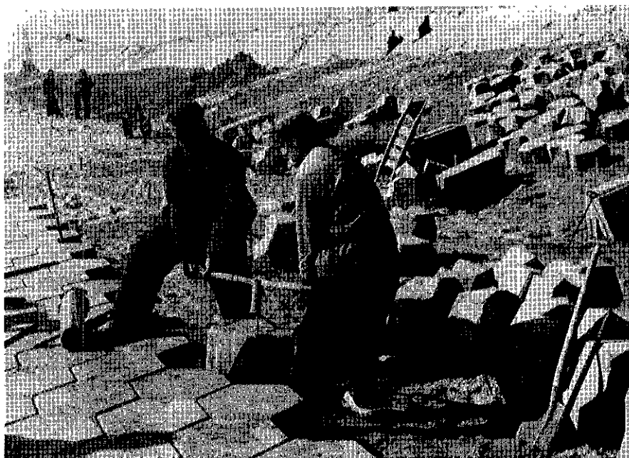
Het plaatsen van de betonblokken
