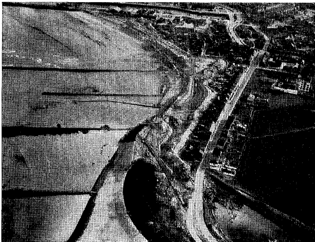
Overzicht van de duinverzwaring in uitvoering
