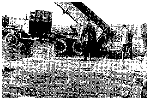
Het storten van de asfalt- beton
